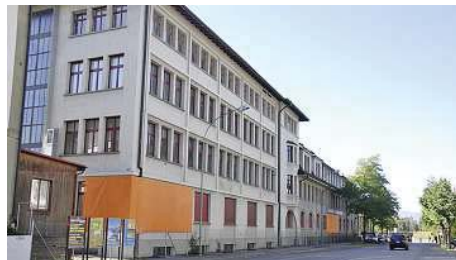
Oktober 2010: Die alten Industriebauwerke stehen noch. Die orangenen Elemente dienen als Hilfe für die spätere Gestaltung der Fassaden. Marc Imboden
