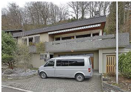
In diesem Haus in Heimberg brach ein Brand aus.
