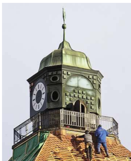
Dachsanierung am Pestalozzi-Schulhaus.
