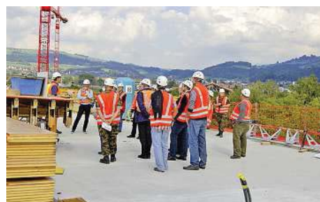
Exklusive Besichtigung: Behörden und Gemeindevorteiler konnten sich ein Bild der aktuellen Baulage beim Bypass Thun-Nord machen. Heinz Schürch
