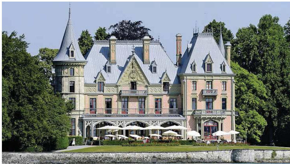
Die Stadt will das Schloss Schadau innen sanieren und es künftig besser vermarkten. Der Vertrag mit dem bisherigen Pächter wird nicht erneuert. Patric Spahn
